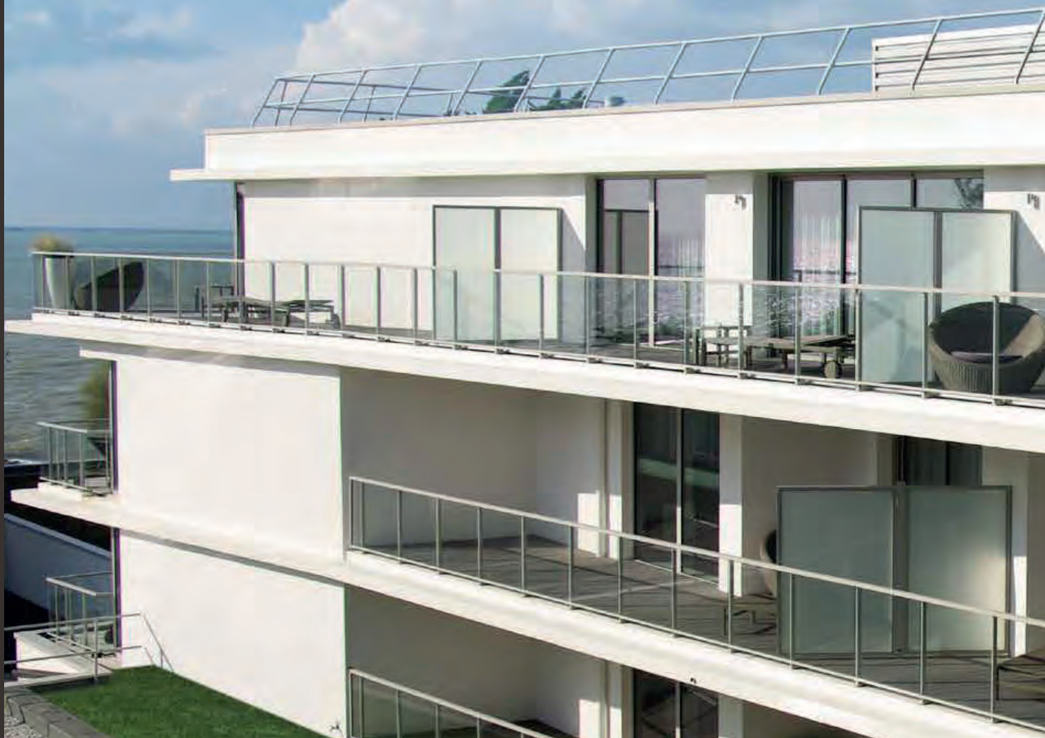
Séparations avec vitrage granité.
