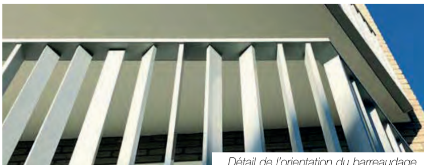
Détail de l'orientation du barreaudage.
