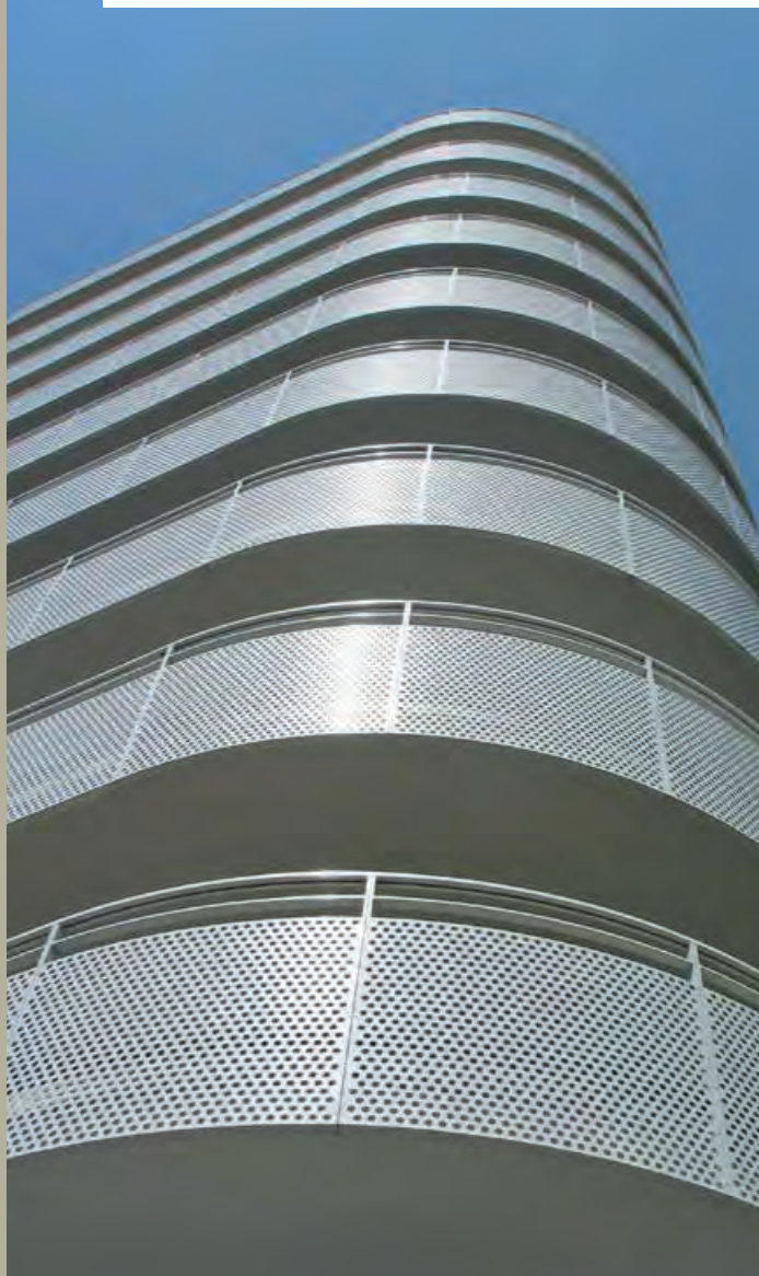
FERIA version filant, lisse intermédiaire, remplissage en tôle perforée. Conception garde-corps, Philippe Gazeau Architecte.
