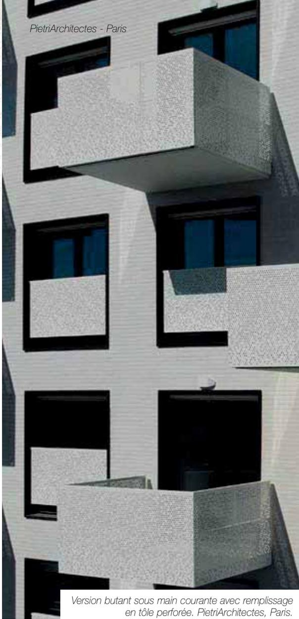
Version butant sous main courante avec remplissage en tôle perforée. PietriArchitectes, Paris.
