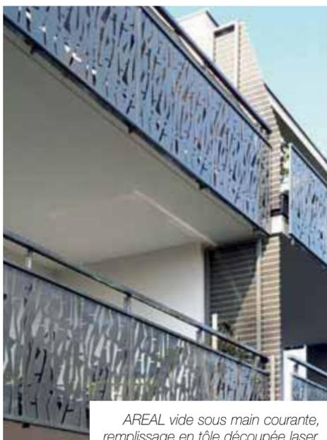
AREAL vide sous main courante, remplissage en tôle découpée laser.
