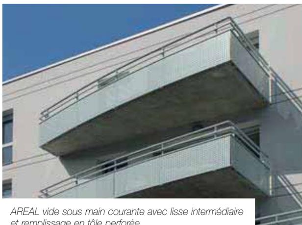
*AREAL vide sous main courante avec lisse intermédiaire et remplissage en tôle perforée.*
