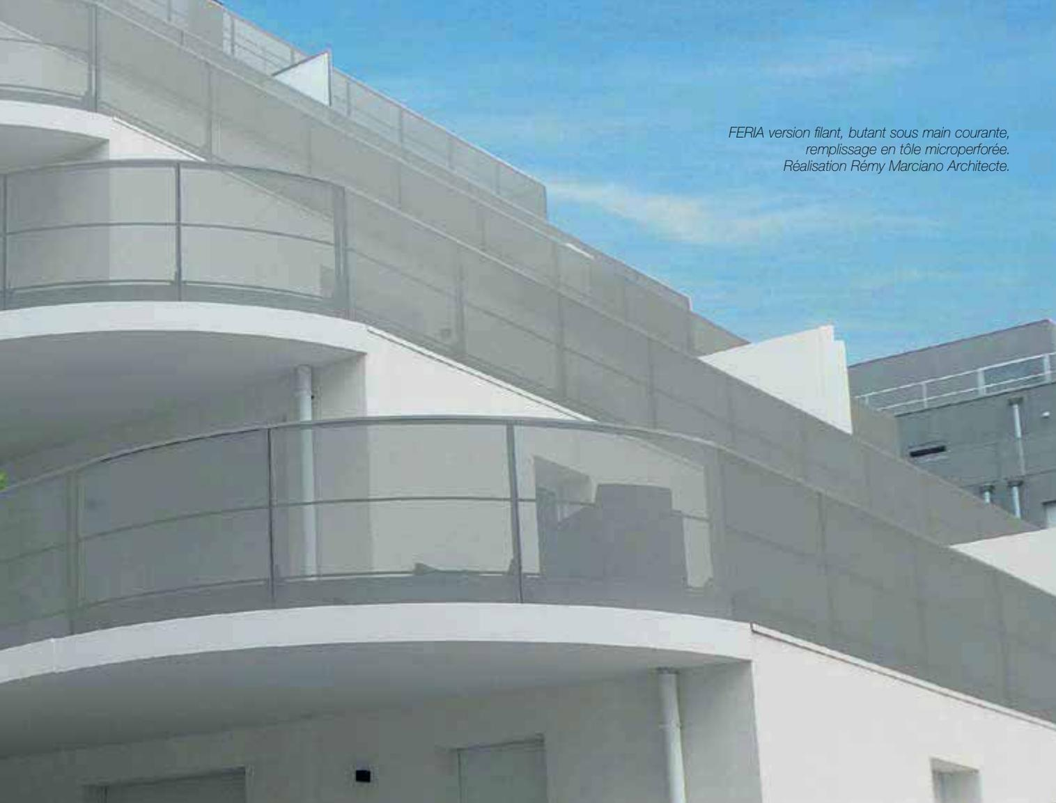
*FERIA version filant, butant sous main courante, remplissage en tôle microperforée. Réalisation Rémy Marciano Architecte.*
