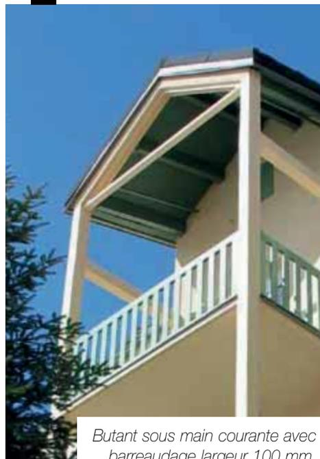
*Butant sous main courante avec barreaudage largeur 100 mm.*
