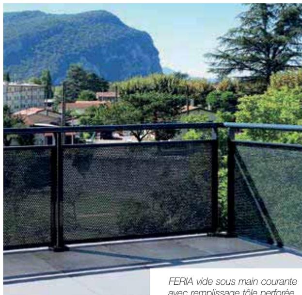
*FERIA vide sous main courante avec remplissage tôle perforée.*
