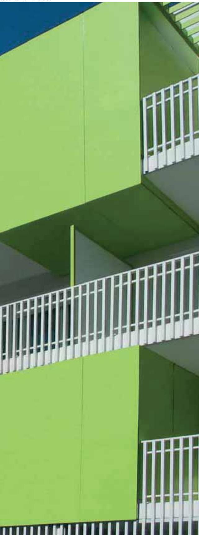
Ce modèle propose un barreaudage aluminium carré (40 x 40) à entraxe fixe ou variable. La main courante en partie haute se trouve en arrière-plan du barreaudage.
