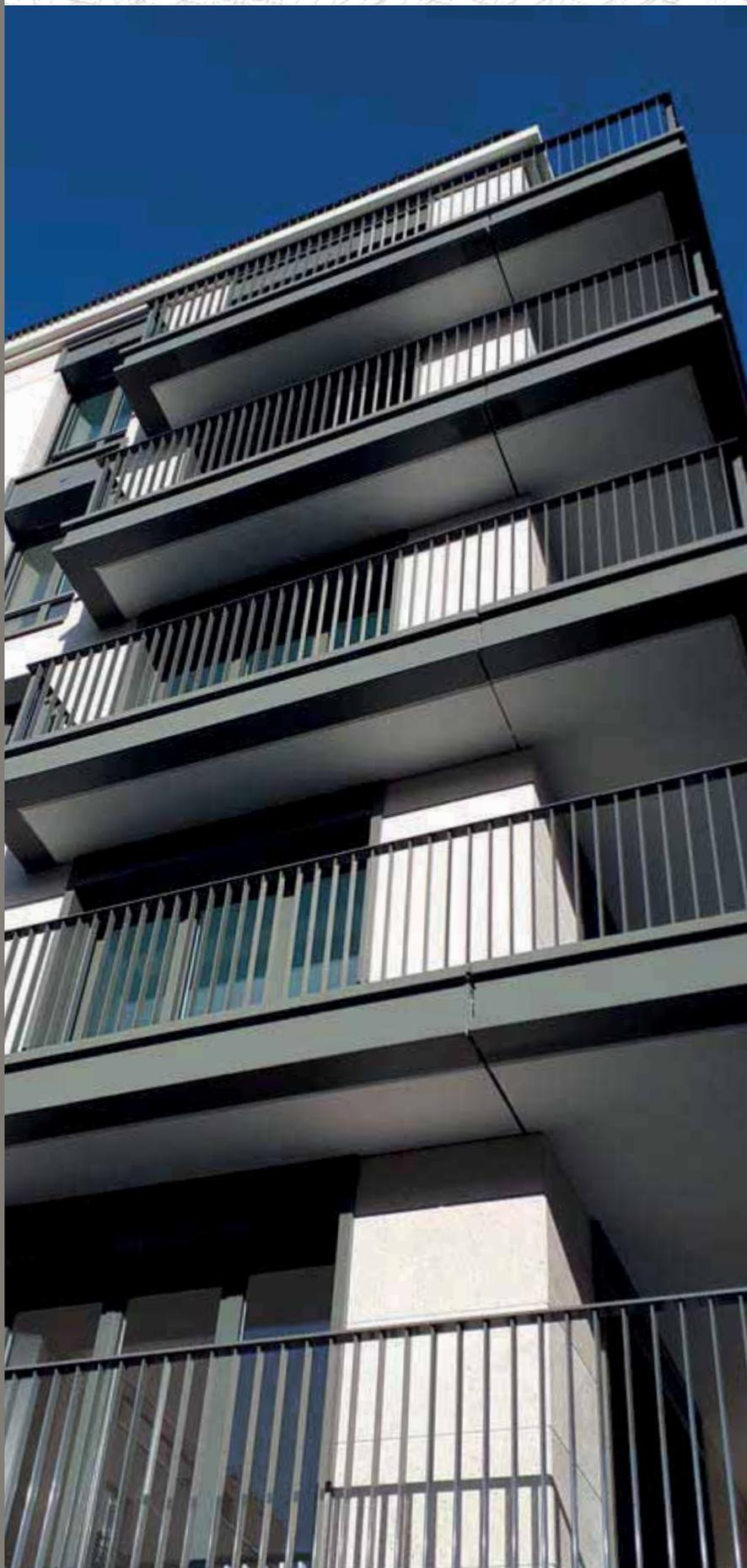
**FERIA MODURAL** est un concept de garde-corps aéré permettant une intégration simple et efficace aux différents types d'architecture existants. Aucune pièce de liaison n'est apparente afin de préserver un aspect épuré se rapprochant des références acier, avec tous les avantages de l'aluminium thermolaqué (une très bonne protection contre la corrosion, un entretien minimum et un éclat durable).
