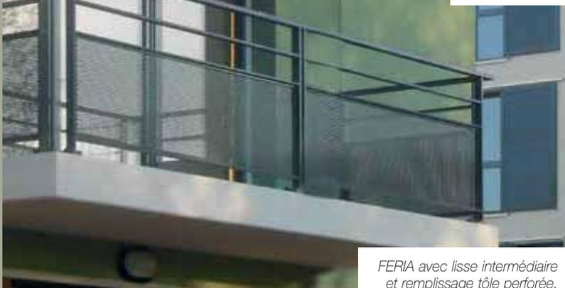
*FERIA avec lisse intermédiaire et remplissage tôle perforée.*
