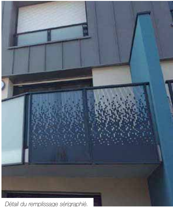
Détail du remplissage sérigraphié.
