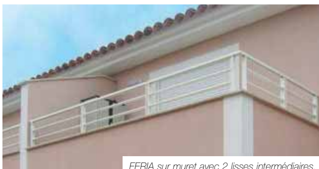
FERIA sur muret avec 2 lisses intermédiaires.
