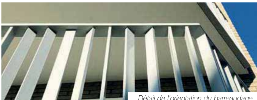
Détail de l'orientation du barreaudage.
