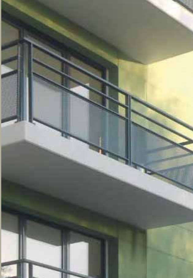
FERIA avec 2 lisses intermédiaires, vitrage 44/2 clair et lisse décorative.
