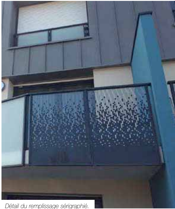
Détail du remplissage sérigraphié.
