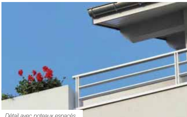
Détail avec poteaux espacés.
