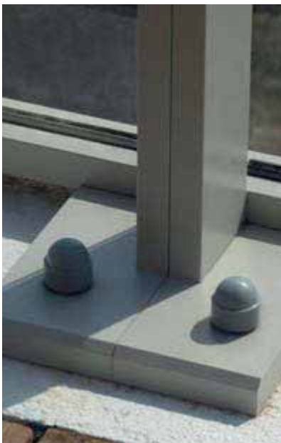
Vue intérieure / Détail du sabot.
