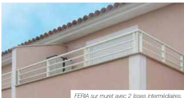
FERIA sur muret avec 2 lisses intermédiaires.
