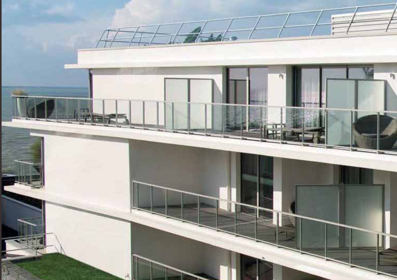
Séparations avec vitrage granité.
