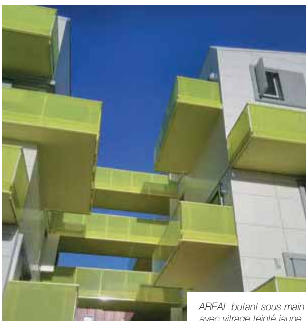
AREAL vide sous main courante avec lisse intermédiaire et remplissage en tôle perforée.
