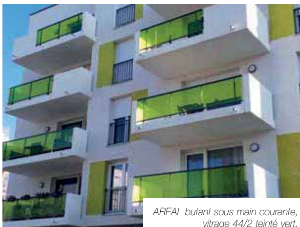
AREAL butant sous main courante, vitrage opale 44/2.
