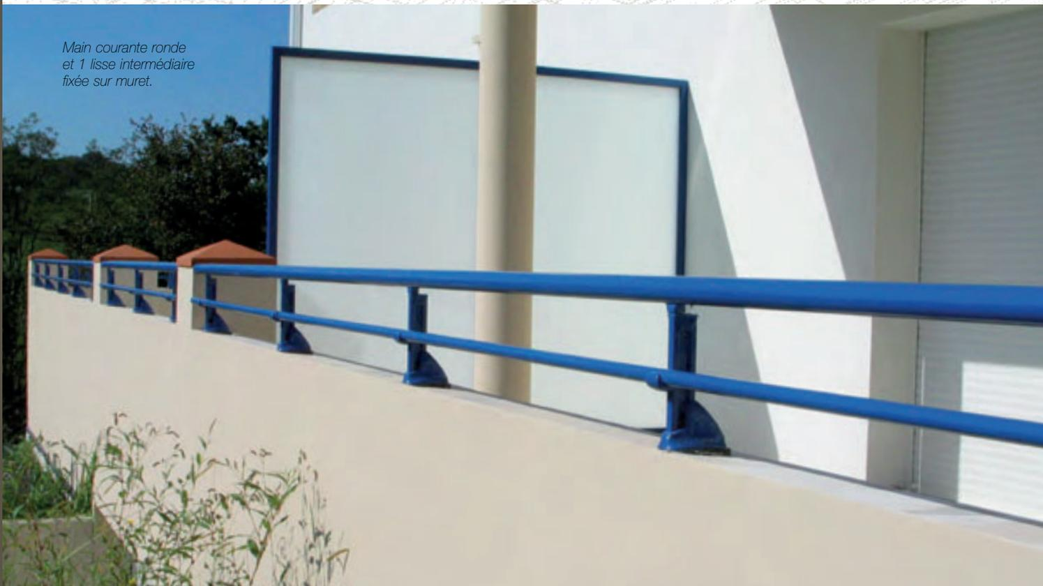
Sur ou contre muret, les garde-corps à lisses horizontales apportent une grande liberté de création. Les profils épousent les maçonneries droites ou cintrées et leurs différents types de fixation s'adaptent à tous les supports, dans le respect des normes de sécurité.
