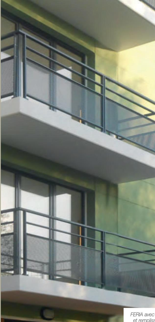
*FERIA avec lisse intermédiaire et remplissage tôle perforée.*
