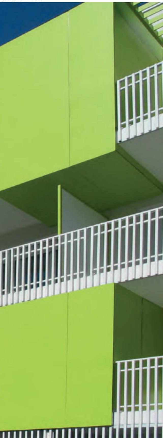
Ce modèle propose un barreaudage aluminium carré (40 x 40) à entraxe fixe ou variable. Main courante en partie haute en arrière plan.
