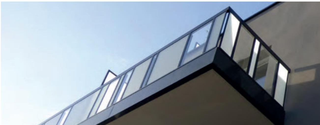
Les bandeaux **HORIZONTAL** possèdent la particularité de pouvoir se fixer directement aux barreaux supports des garde-corps et rester ainsi indépendants de la maçonnerie.
