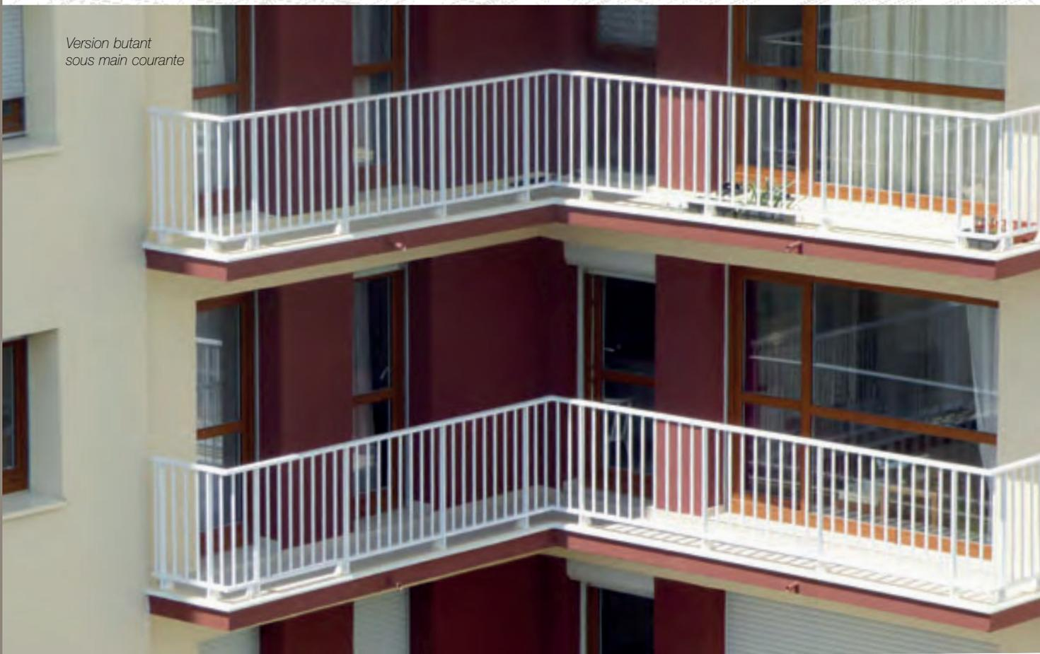
Le garde-corps **AXTAR** possède la particularité d'intégrer chaque raidisseur dans l'axe du barreaudage vertical afin de le dissimuler et de ne laisser apparaître que le sabot de fixation sous la lisse basse.
