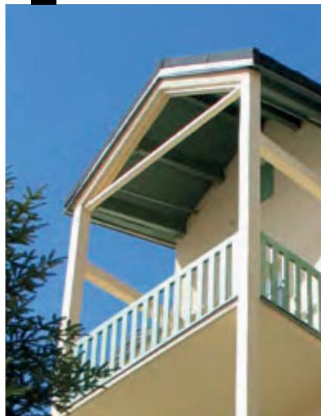
*Butant sous main courante avec barreaudage largeur 100 mm.*
