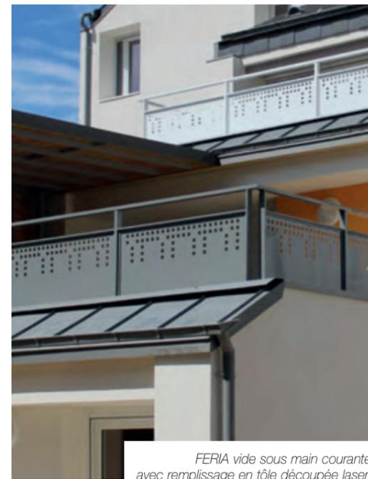
FERIA vide sous main courante avec remplissage en tôle découpée laser.
