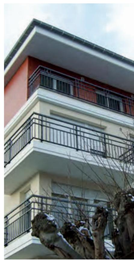
Fixation sur dalle avec barreaux-supports en aluminium moulés
