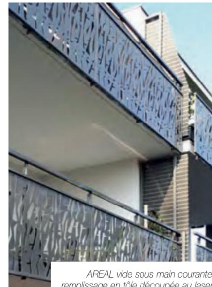
AREAL vide sous main courante, remplissage en tôle découpée au laser.
