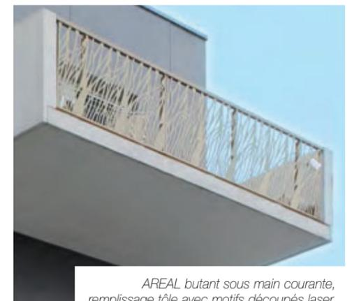
AREAL butant sous main courante, remplissage tôle avec motifs découpés laser.
