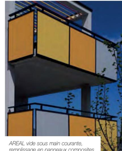
AREAL vide sous main courante, remplissage en panneaux composites.
