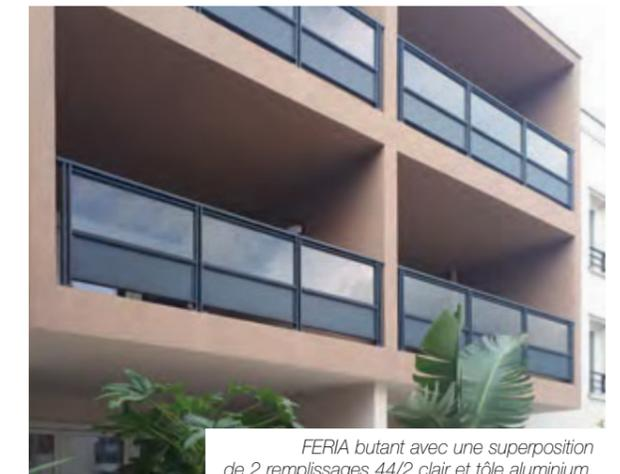
*FERIA butant avec une superposition de 2 remplissages 44/2 clair et tôle aluminium.*
