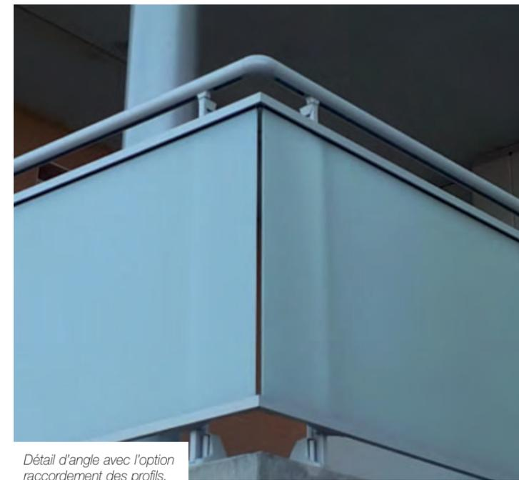
Détail d'angle avec l'option raccordement des profils.
