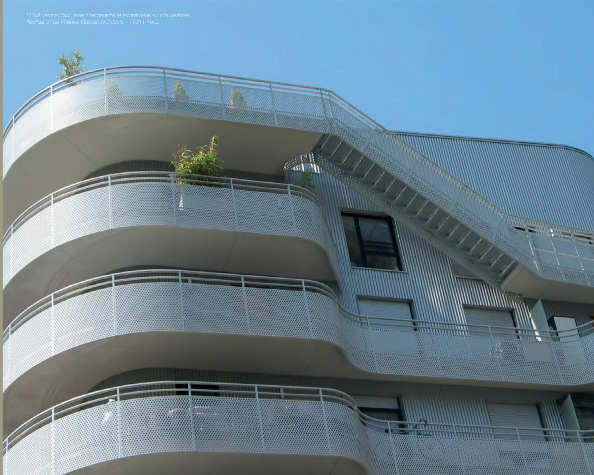
**FERIA** est un garde-corps aluminium « nouvelle génération » conçu à partir de profilés qui imitent parfaitement le style épuré de l'acier.
