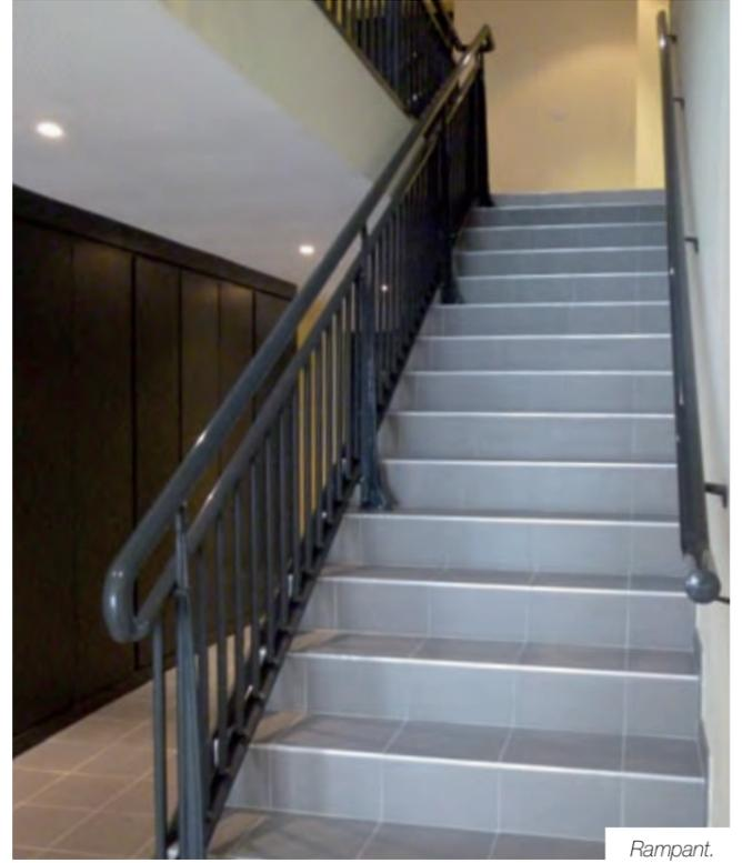
Le garde corps **ARTIK** est le produit idéal pour les cages d'escalier. Son barreaudage articulé lui autorise une mise en œuvre très simple en position rampante. **ARTIK** est proposé en version butant ou vide sous main courante.
