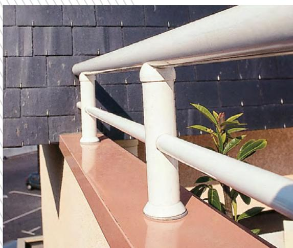
Couvantine en tôle d'aluminium fixée sur muret par support cannelé.
