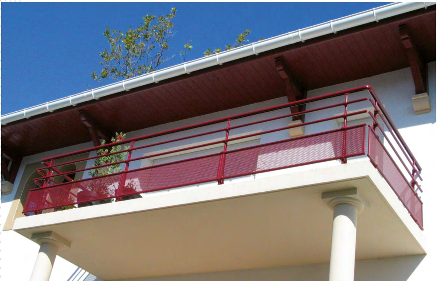
*Athys sur dalle avec soubassement en tôle aluminium perforée.*
