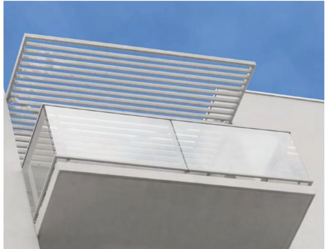
*FERIA version filant, butant sous main courante, remplissage en verre 44/2 réfléchissant.*
