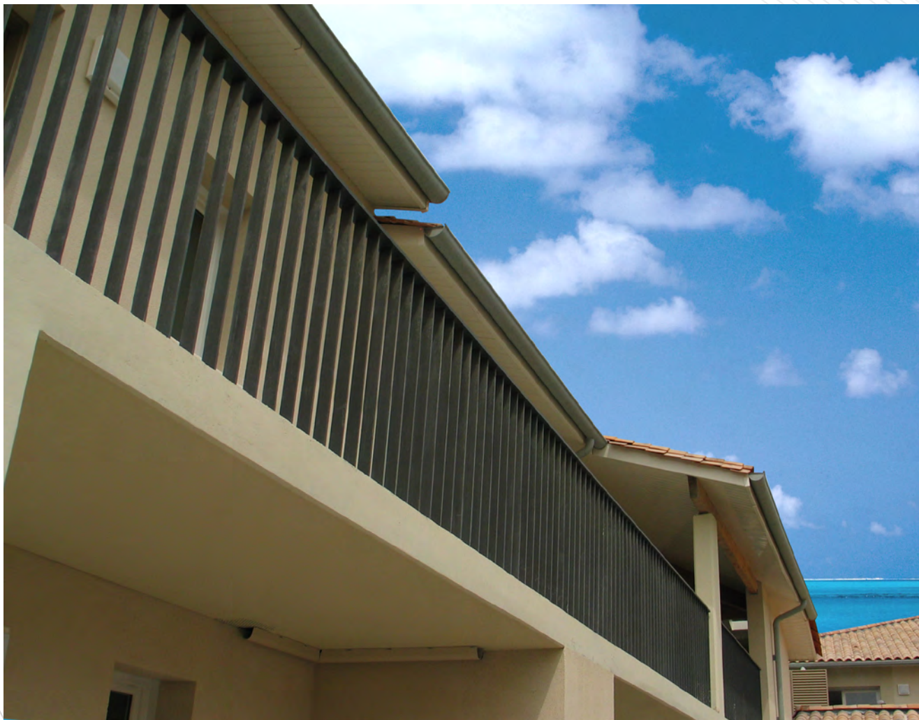
MODURAL avec barreaudage de section 50 x 15 mm.
