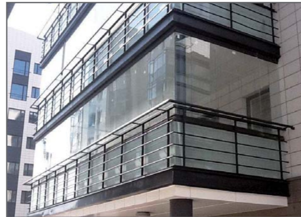
▲ Chantier Novi Gorod à Saint-Petersburg en Russie.
