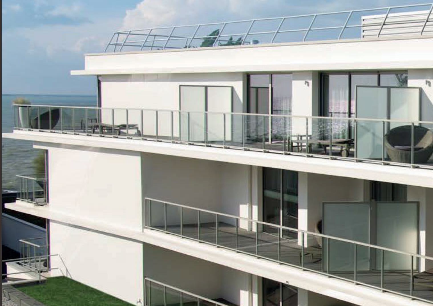
Séparations avec vitrage granité.
