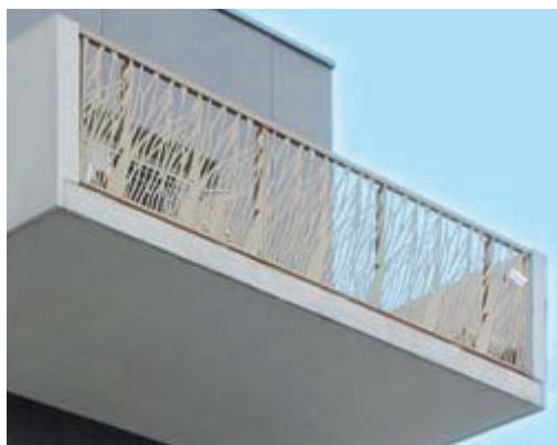
AREAL butant sous main courante, remplissage tôle avec motifs découpés laser.
