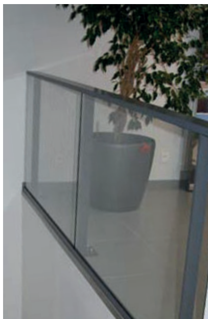
Vue extérieure avec garde au sol à 5 mm.
