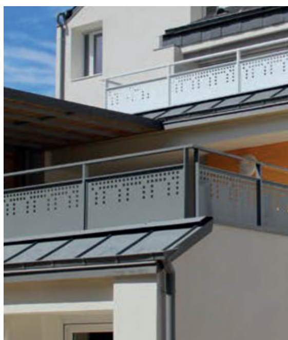
FERIA vide sous main courante avec remplissage en tôle découpée laser.
