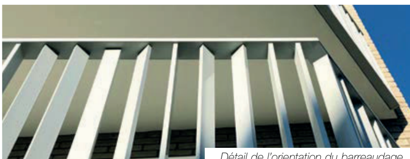
Détail de l'orientation du barreaudage.
