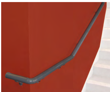
Main courante d'escalier.
