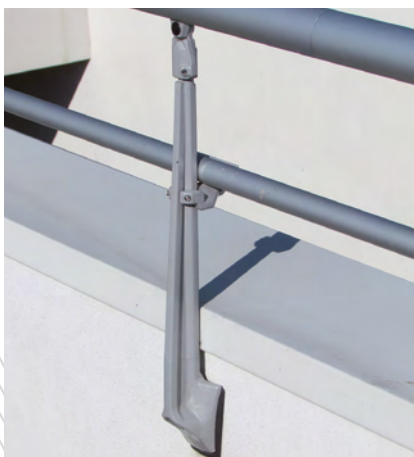
Barre support en aluminium moulé contre muret.
