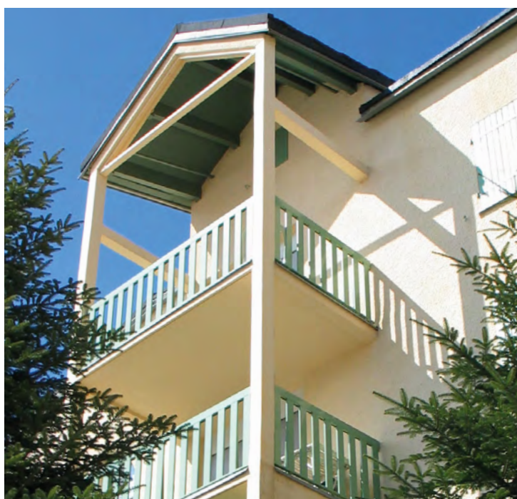
Butant sous main courante avec barreaudage largeur 100 mm.
