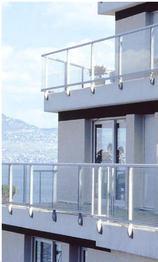
AREAL butant sous main courante, vitrage 44/2 clair, fixation en applique.
