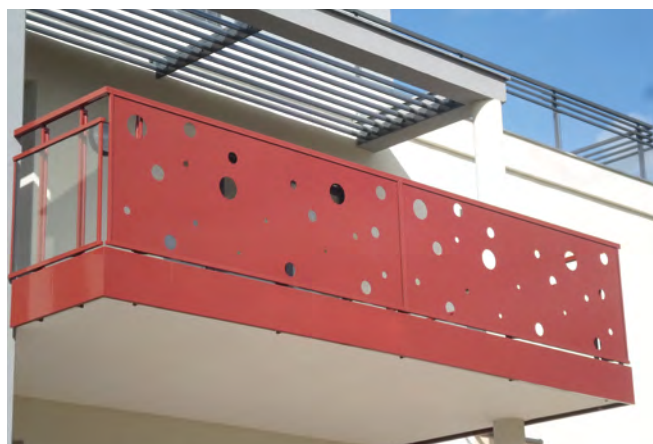
AREAL butant sous main courante remplissage tôle découpe laser et bandeau d'habillage du nez de dalle.
