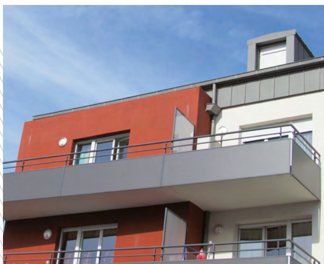
AREAL une lisse intermédiaire, remplissage en panneau composite.
