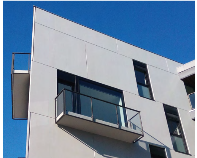
FERIA version passant devant dalle remplissage en verre 44/2 clair butant sous main courant.
